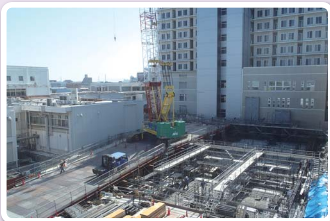
(工事風景5月17日現在)
