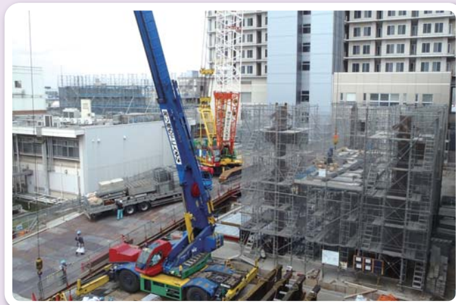
(工事風景7月2日現在)
