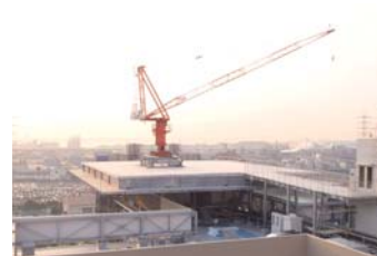
完成したヘリポート
