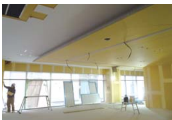
内装工事の様子
