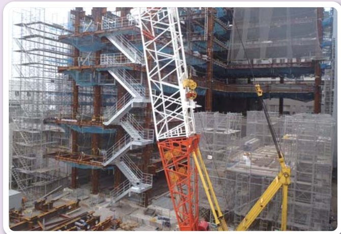
(工事風景8月30日現在)
