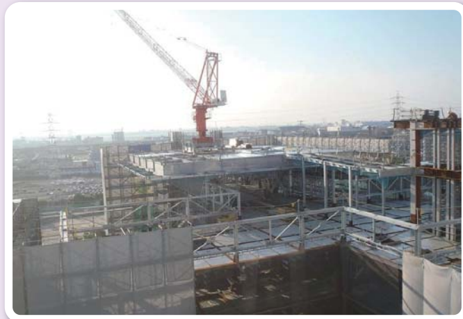
(工事風景10月3日現在)
